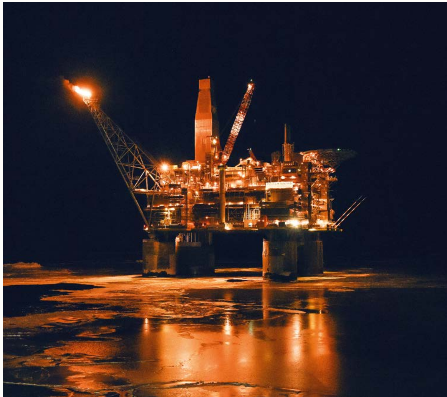
Морская нефтедобывающая платформа «Пильтун-Астохская-Б»
