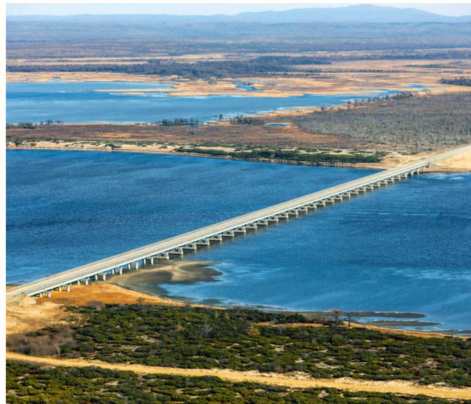
В рамках проекта разработки месторождения Чайво («Сахалин-1») был построен мост через залив длиной 830 м. Он считается самым прочным в восточной части России, а также превосходит по длине знаменитые переходы через великие сибирские реки – Иртыш и Обь.
