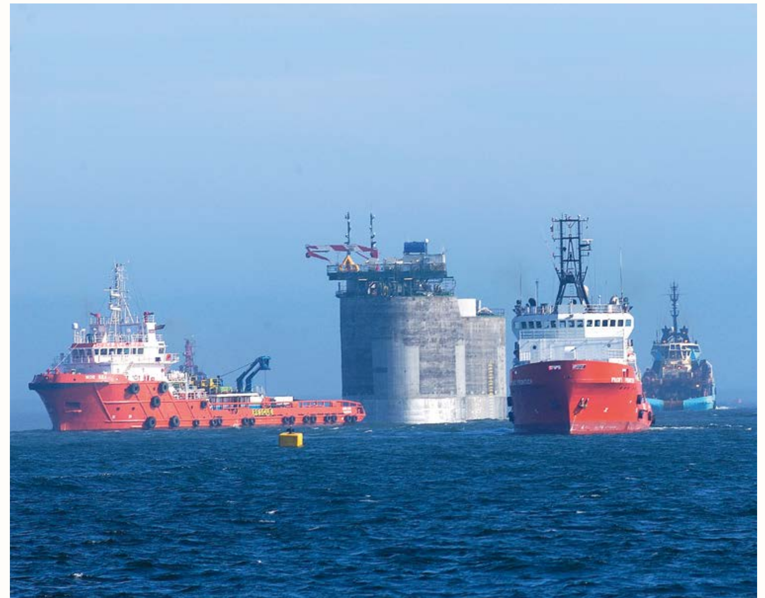
Установка железобетонного основания гравитационного типа платформы «Лунская-А»
