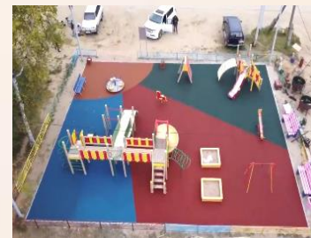
Ремонт детской площадки в пгт. Ноглики, ул. Ак. Штернберга, д. 2
