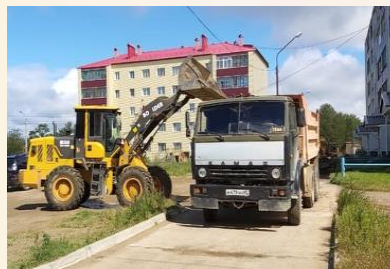
Ремонт дворовых территорий в пгт. Ноглики ул. Советская, д. 48, ул. Квартал, д. 1,2
