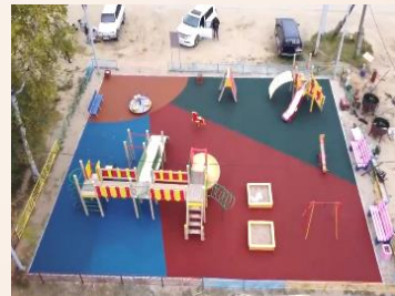
Ремонт детской площадки в пгт. Ноглики, ул. Ак. Штернберга, д. 2
