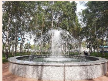
Капитальный ремонт фонтана в пгт. Ноглики
