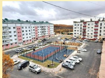
Капитальный ремонт дворовой территории пгт. Ноглики ул. Депутатская, д. 6
