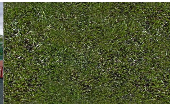
Капитальный ремонт (озеленение) двора по ул. Депутатская, дом 6 в пгт. Ноглики
